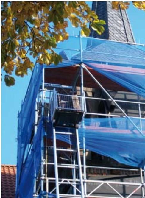
Das Turmdach ist an den undichten Stellen ausgebessert worden und muss im nächsten Schritt komplett erneuert werden.
